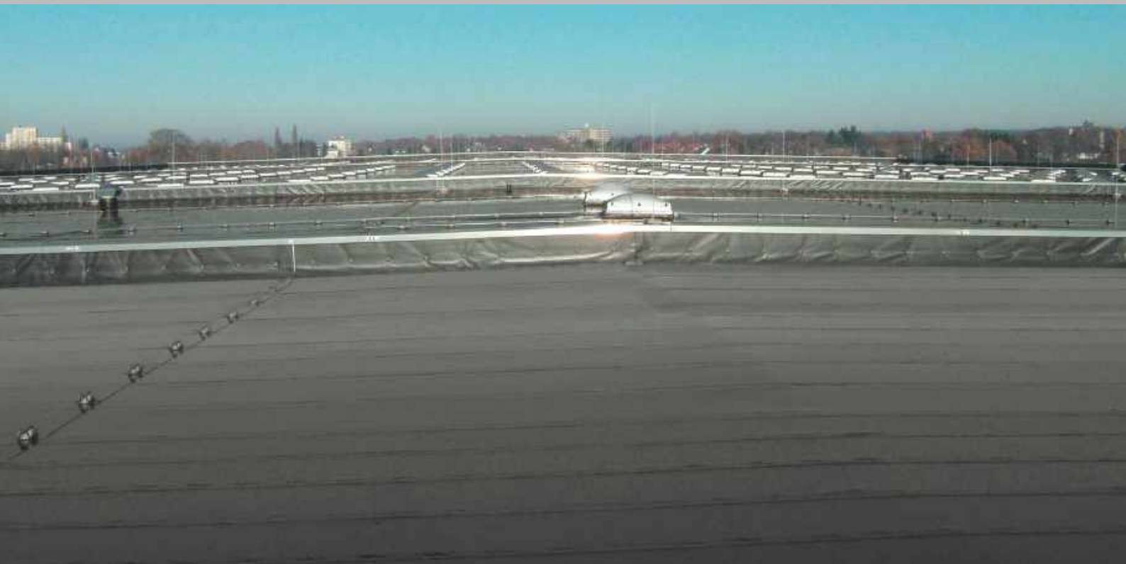
H & N-Versandlager, Hann. Münden ExtruBit Dachabdichtung, 11.000 m 2
