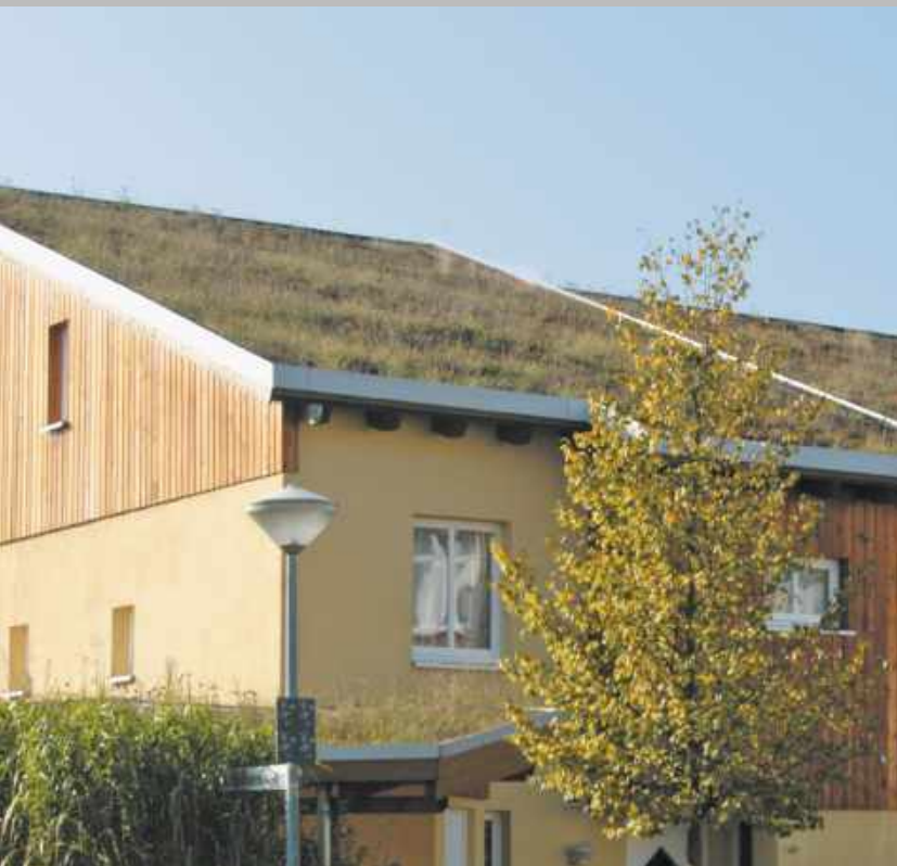
Gründach-Siedlung Bovenden ExtruBit-Dachabdichtung, 850 m 2
