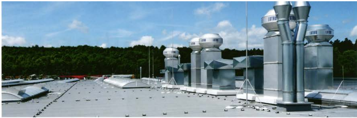
Gute Planlage, effiziente und ganzjährige Verlegbarkeit: Dichtungsbahnen aus FPO/TPO sind die moderne Form der Flachdachabdichtung.
