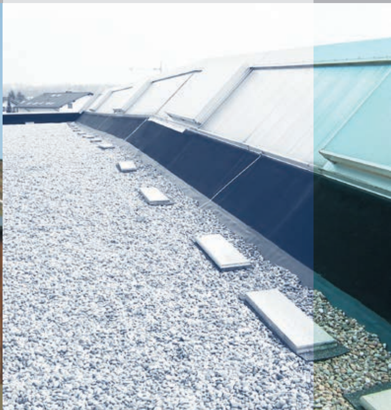
Baumarkt, Baden-Baden ExtruBit Dachabdichtung, 4.500 m 2
