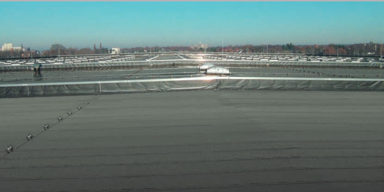
H & N-Versandlager, Hann. Münden ExtruBit Dachabdichtung, 11.000 m 2
