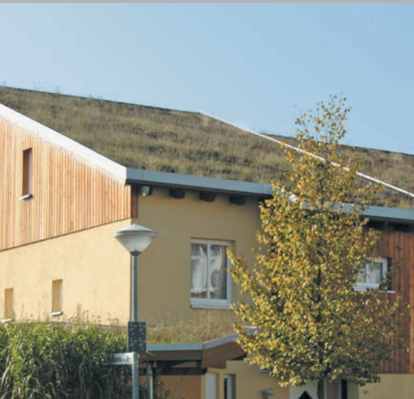
Gründach-Siedlung Bovenden ExtruBit-Dachabdichtung, 850 m 2
