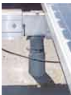
Изоляция кровельного отверстия с помощью ExtruPol.
