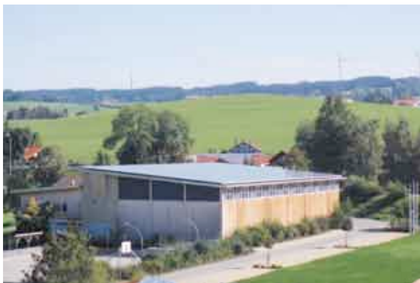
Плоские крыши построек идеальны для фотовольтажных установок/установки солнечных батарей.
