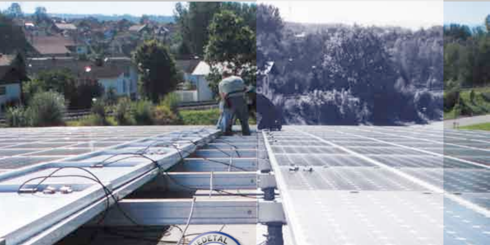
Монтаж фотовольтажной комплектной системы фирмы Schedetal.
