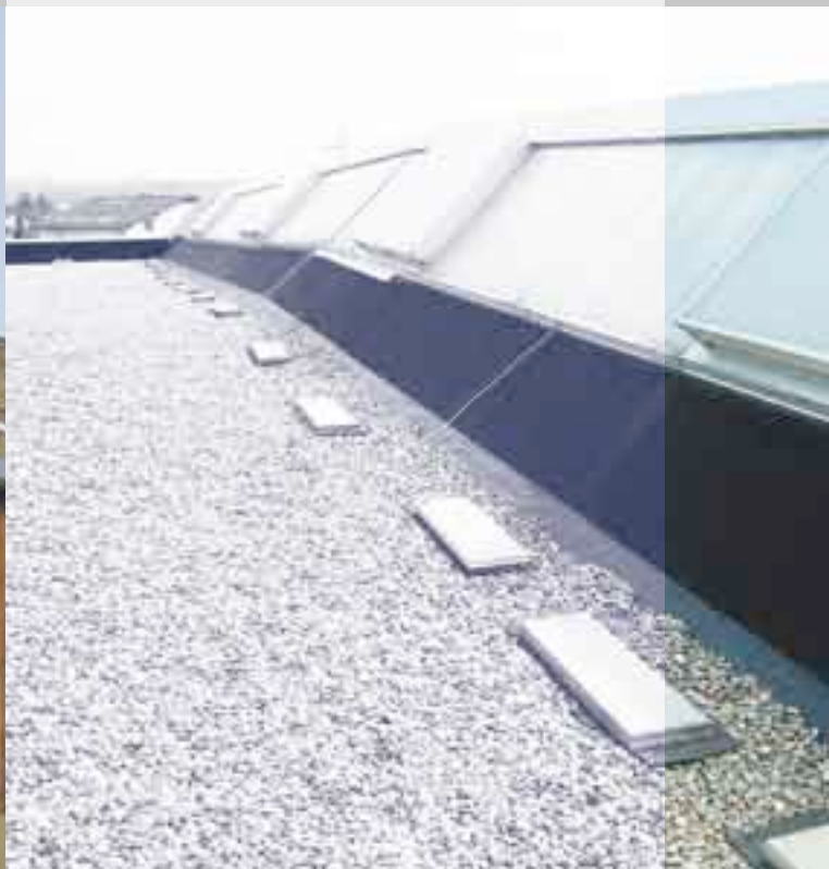
Баумаркт г.Баден – Баден ExtruBit/Экструбит изоляция крыши, 4.500 м 2
