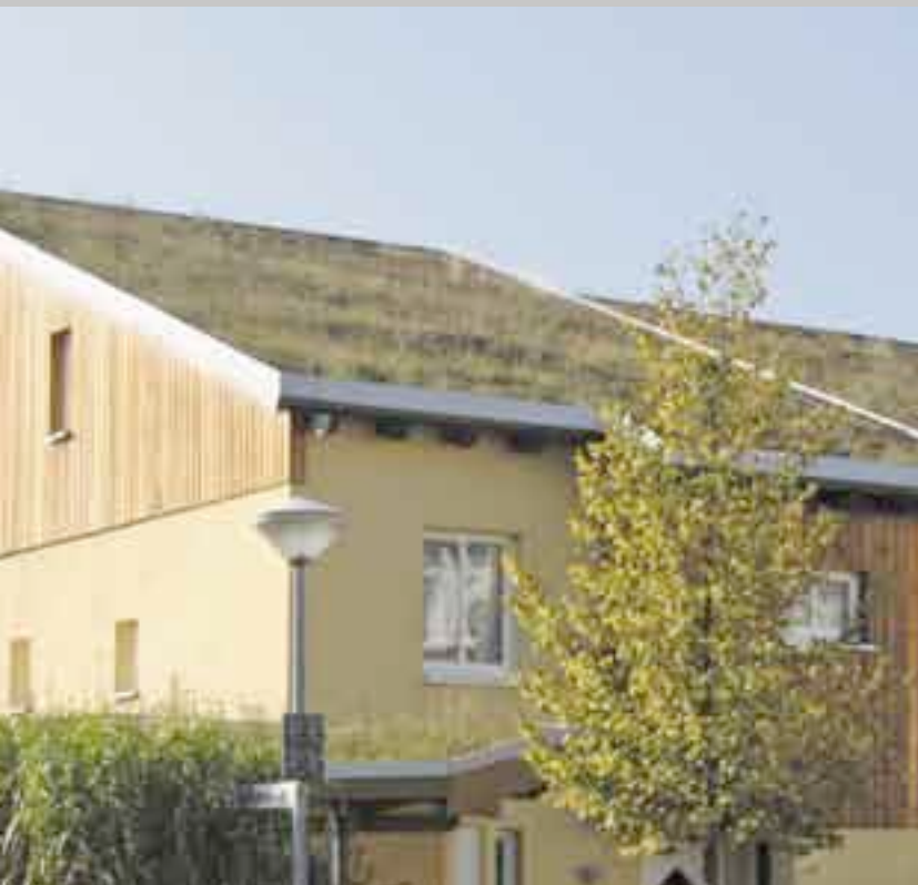
Поселение с озеленёнными крышами в г.Бовенден ExtruBit/Экструбит изоляция крыши, 850 м 2
