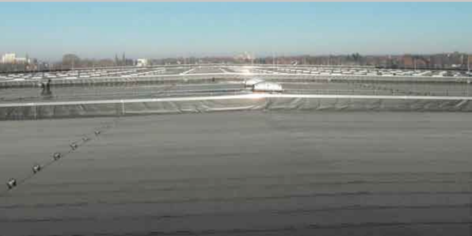
Складские помещения фирмы H&N в г.Ханн.Мюнден Extrubit/Экструбит Изоляция крыши площадью 11.000 м 2
